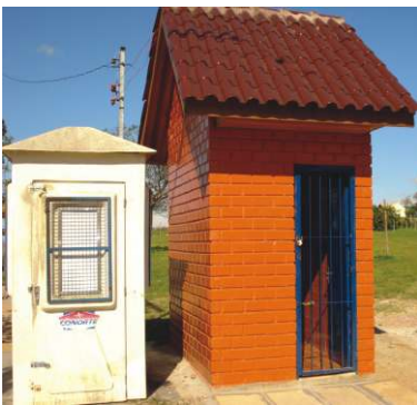
A obra do banheiro do terminal foi concluída.
